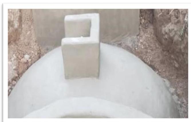
C'est l'estomac du digesteur. Il est chargé de bactéries méthaniseur qui assurent la dégradation de la matière organique. Suivant un principe d'occupation du vide, le volume de l'effluent liquide baisse et laisse place au gaz qui se produit suivant les différentes phases biologiques.
