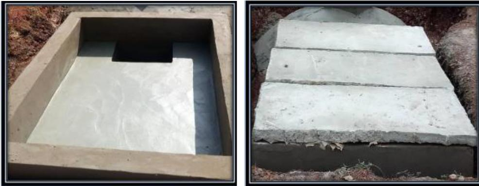
C'est la partie de récupération du digestat liquide et du digestat solide. Le digestat solide est le sédiment qui tapisse le fond du bac surnagé par le sédiment liquide. C'est la matière organique riche en fertilisant qui est utilisé en agriculture.
