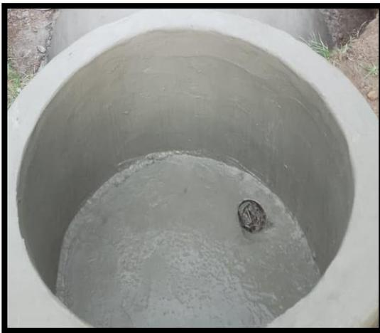
C'est la partie du dispositif pour alimenter le digesteur. Elle communique avec le dôme de chargement par un tuyau PVC incliné pour l'écoulement gravitaire de l'effluent. L'effluent est constitué de la bouse de vache ou autre matière organique macéré avec de l'eau
